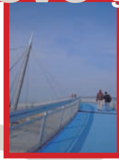
Foto L. D'Agostino Il Ponte del mare di Pescara
