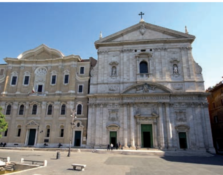
Chiesa di Santa Maria in Vallicella
